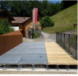
Die Brücke liegt auf dem neu erstellten Betonfundament. Längsgespannte IPE-Profile bilden das primäre Tragwerk. Für das vorkorrodierte Geländer kam Cortenstahl von 12 mm Stärke zur
