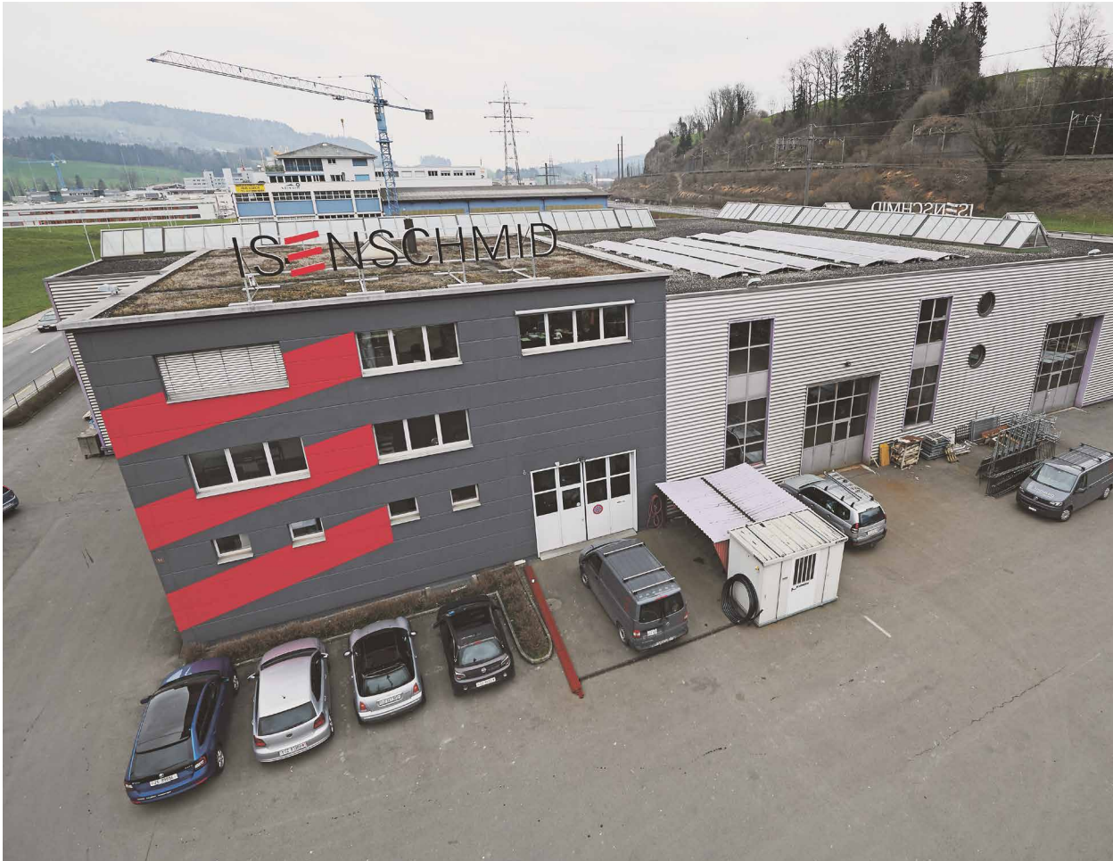
Die Photovoltaikanlage (rechts) auf dem Dach des neu gestalteten Firmengebäudes der Isenschmid AG.
